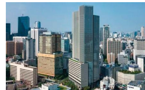
図1-4 地区内残留地区 赤坂、六本木地区
