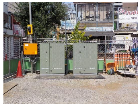
図 5-7 防災生活道機能維持事業を活用し無電柱化した事例 (目黒区原町一丁目)
