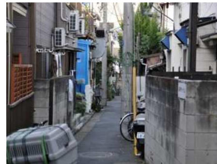
道路が未整備のまま木造建築物が密集
