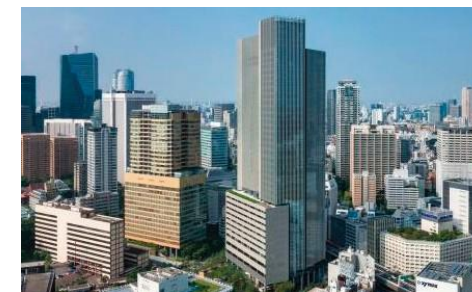
図1-4 地区内残留地区 赤坂、六本木地区
