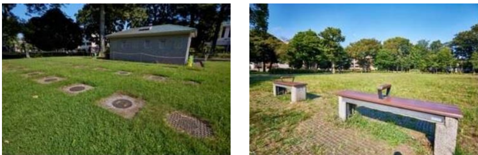
図5-8 マンホールトイレ・かまどベンチ例（品川区）
