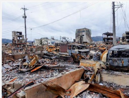
輪島市朝市の被災状況
