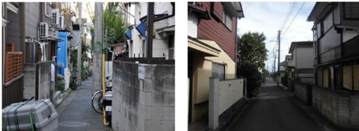
図：木造住宅密集地域内の状況
