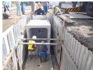
◆電線の地中化工事 (荒川区荒川)
