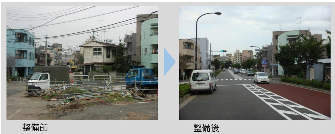
図 3-2 一般延焼遮断帯の整備例
